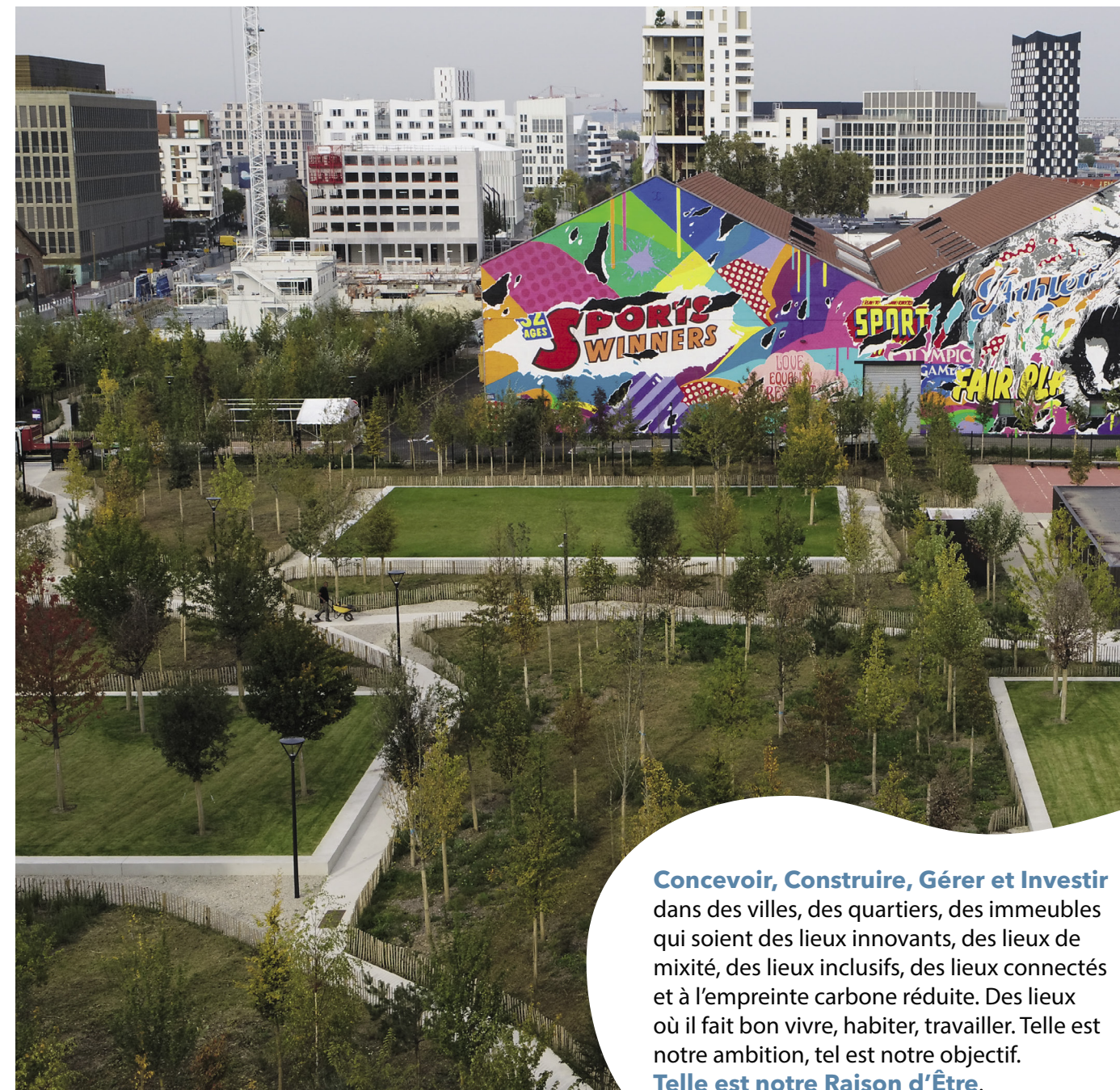
Parc des Portes de Paris - Aubervilliers (93)
