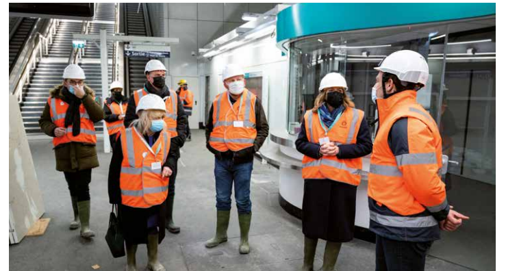
» Mardi 25 janvier 2022 Visite du chantier de la ligne 12 Mardi 25 janvier, Karine Francllet, Maire d'Aubervilliers, des élus et des représentants de la RATP ont visité le chantier de la ligne 12. Ils ont parcouru à pied le trajet entre les futures stations Aimé Césaire (15 000 voyageurs attendus) et Mairie d'Aubervilliers (22 000 voyageurs attendus) à vingt mètres de profondeur.
