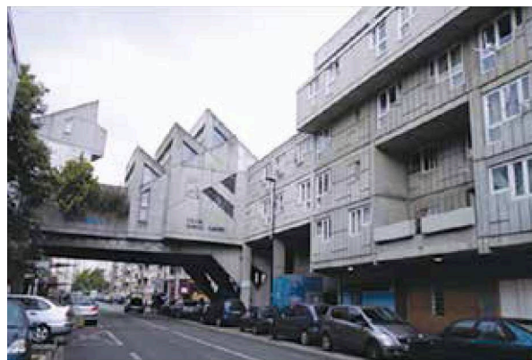
Maladrerie à Aubervilliers
