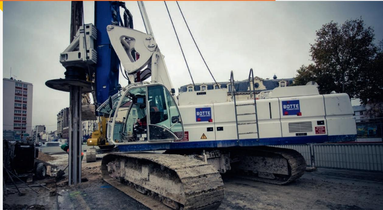
À la suite d'un aléa géotechnique (importantes venues d'eau), une nouvelle méthode va être utilisée pour réaliser le puits d'accès pompiers Waldeck-Rousseau. Une machine de grande dimension sera ainsi installée pour construire une enceinte étanche qui
