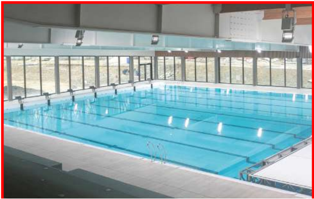
» Le centre nautique Camille-Muffat comprend un bassin sportif de 50 m avec 8 couloirs, et un bassin d'apprentissage de 25 m.
